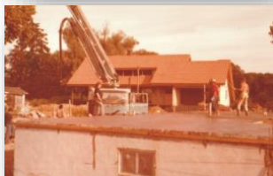
Bilder von der Baustelle 1979
