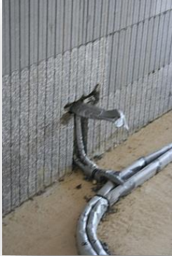
Heizkörper- anschluss
