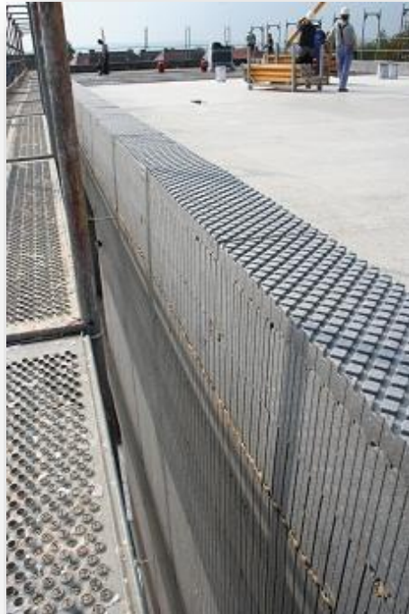
Attika mit Brüstungsdämmplatte
