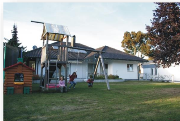
Das Haus 30 Jahre später – noch immer ein Haus das den aktuellen Wärmestandards genügt.
