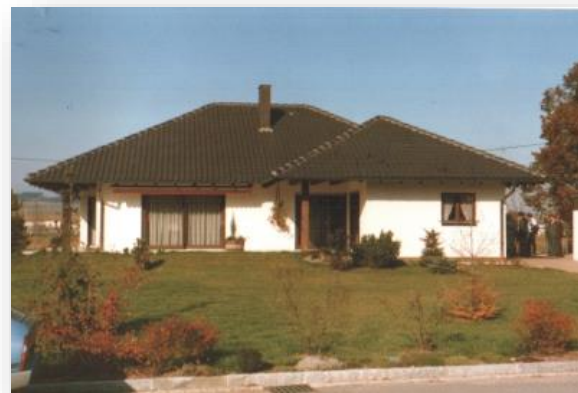
Das erste MAGU Haus, Keltenstrasse 4, In Hüfingen. Aufnahme von 1980
