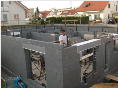
Fenstermontage mit Stahlprofil
