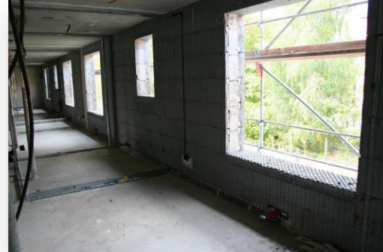
Rohinstallation von Steckdosen und Heizungsleitung
