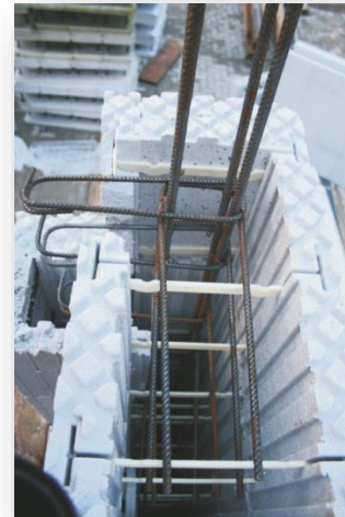
Bewehrung eines Pfeilers
