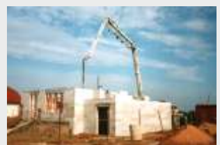
Betonieren in 1990 er
