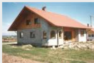
Einfamilienhaus bei Hechingen
