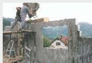
Betonieren mit Krankübel
