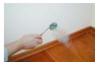
Blowerdoor-Test zeigt die luftundichten Stellen.
