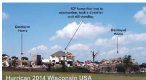
Haus aus Neopor-Schalungssteinen übersteht 2014 den Hurrikan in Wisconsin. In vielen Teilen der Welt ist unsere solide, sehr gut wärmedämmende und wirtschaftliche Bauweise sehr populär.
