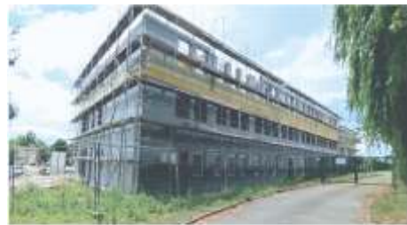
Ärztelhaus in Wiesbaden gebaut mit MAGU ausgeführt mit den entsprechenden Brandriegeln.
